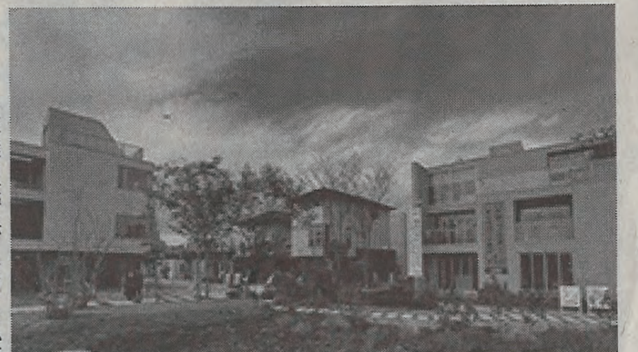
新築も2つのキーワードを意識（都内住宅展示場）
